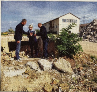
DEM ERDBODEN GLEICHGEMACHT werden die letzten Reste der Philippsburger Salmkaserne. Das Bild zeigt Projektbeauftragte bei einer Begehung. Foto: ber
